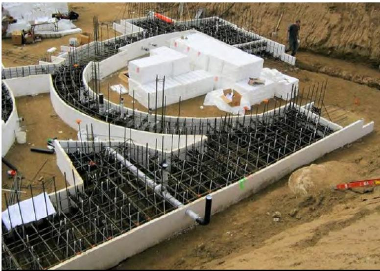
Fig. 3.1 Empattement complexe et placement d'acier d'armature pour zone sismique et commerciale facilement accomplie en utilisant le coffrage **IntegraSpec** avec entretoises et agrafe en "H"
