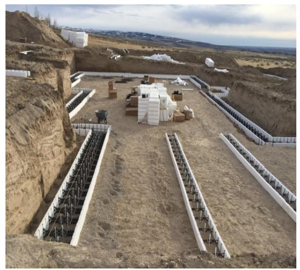
Fig. 3.2 Empattement de largeur et épaisseur traditionnelle fait aisément avec le coffrage **IntegraSpec**
