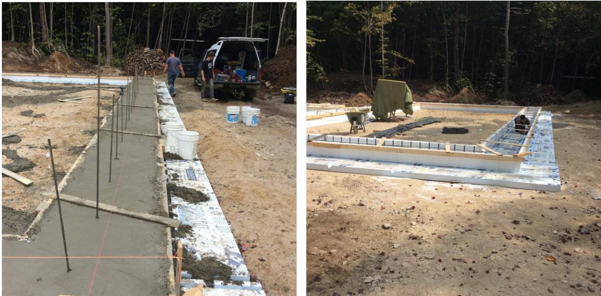
Fig. 3.3 & 3.4 Empattement isolée pour application tel que l'accès du sous sol, garage, grange, entrepôt et autre utilisant le coffrage **IntegraSpec**.
