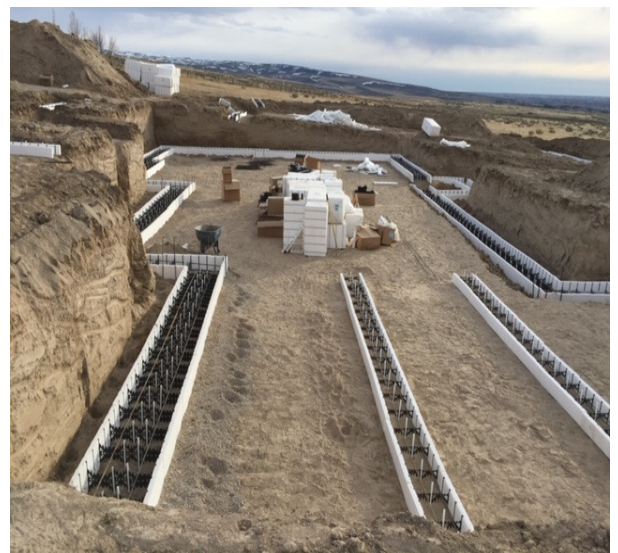
Fig. 3.2 Empatement de largeur et épaisseur traditionnelle fait aisément avec le coffrage IntegraSpec
