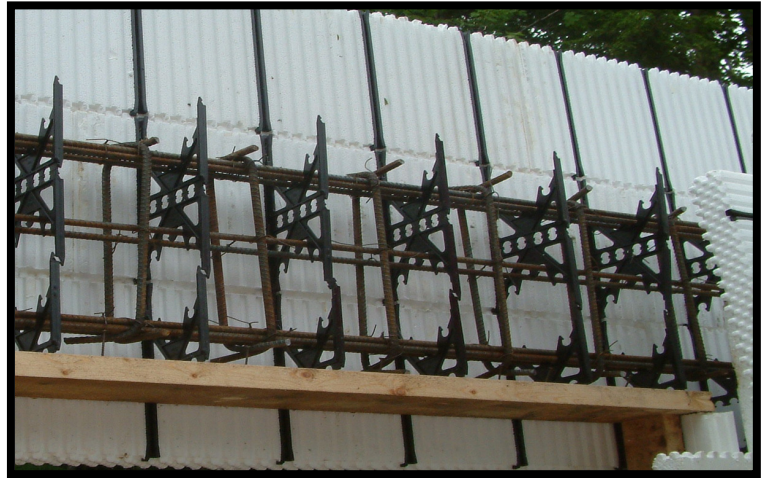
Fig.11.3 Disposition de l'armature du linteau (au besoin).
