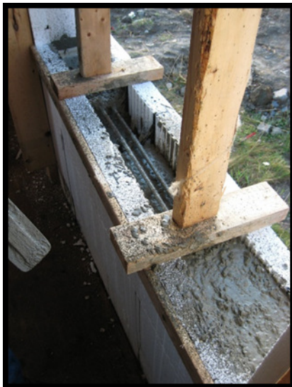
Fig 11.4 Soutient temporaire du linteau appuyé sur le seuil
