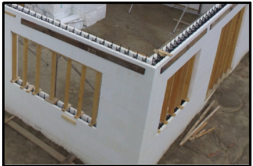
Fig 11.5 Soutient temporaire des linteaux avec colombage.
