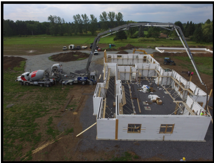
Fig. 17.1 Camion-pompe à béton avec flèche.
