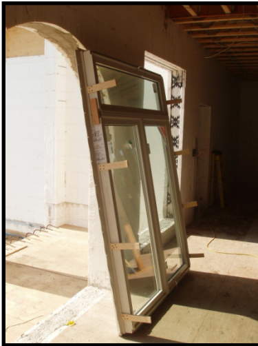
Fig. 10.2 Fenêtre prête à installer avec languettes de bois
