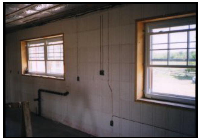
Fig. 12.1b Sorties électriques et câblage, façonné et installé dans des rainures tronçonnées dans le mur IntegraSpec® .
