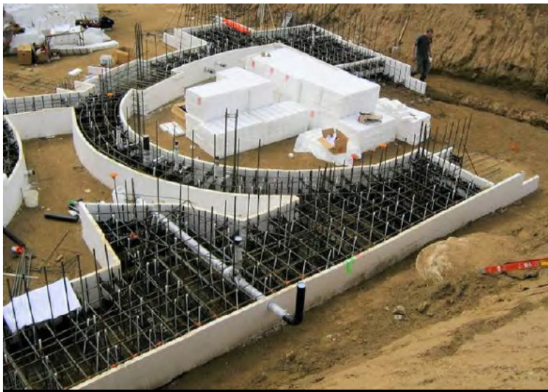
Fig. 3.1 Empatement complexe et placement d'acier d'armature pour zone sismique et commerciale facilement accomplie en utilisant le coffrage IntegraSpec avec entretoises et agrafe en "H"
