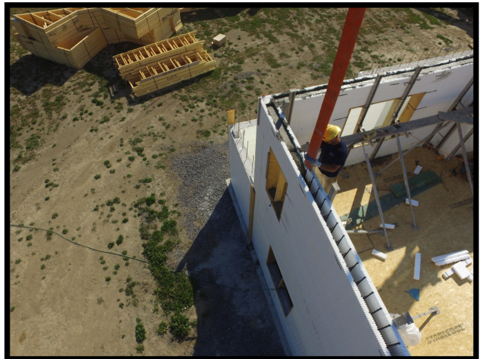
Fig. 17.2 Coulée du béton avec boyau flexible (pliable) de 4" (10 cm) (type: "Mud Snake" illustré)
