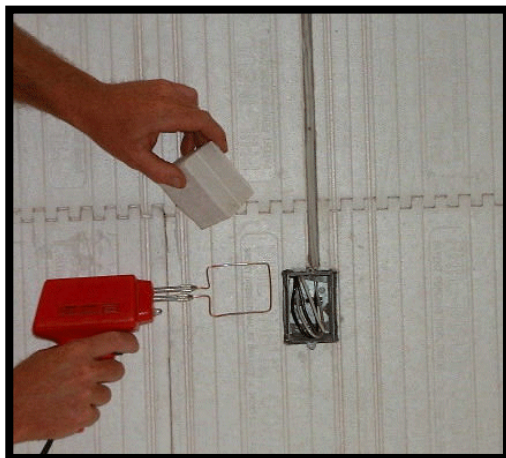
Fig. 12.1a Ouverture pour la boîte électrique est coupée à l'aide d'un pistolet à souder et posée dans le mur IntegraSpec® .
