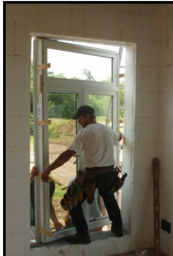
Fig. 10.3 Installation avec languette de contre-plaquée en bois fixé au cadre de de fenêtre pour ainsi être calés et visés au IntegraBuck dans l'ouverture.
