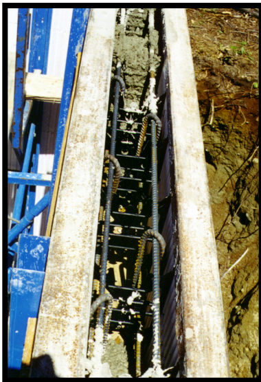
Fig. 13.2 Recouvrement du dessus des panneaux IntegraSpec® avant la coulée du béton. Cela empêche le béton de pénétrer dans ces interconnexions et permet de continuer l'empilement du prochain rang (profilé principal en acier illustré)
