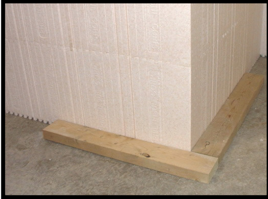
Fig. 5.0 Positionneur de 2" X 4" (5,2 cm x 10,2 cm) fixé au plancher de béton, aux empattements ou à la dalle.
